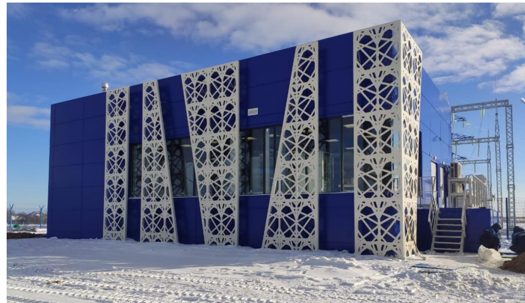
Подстанция «Университет» г. Калуга
